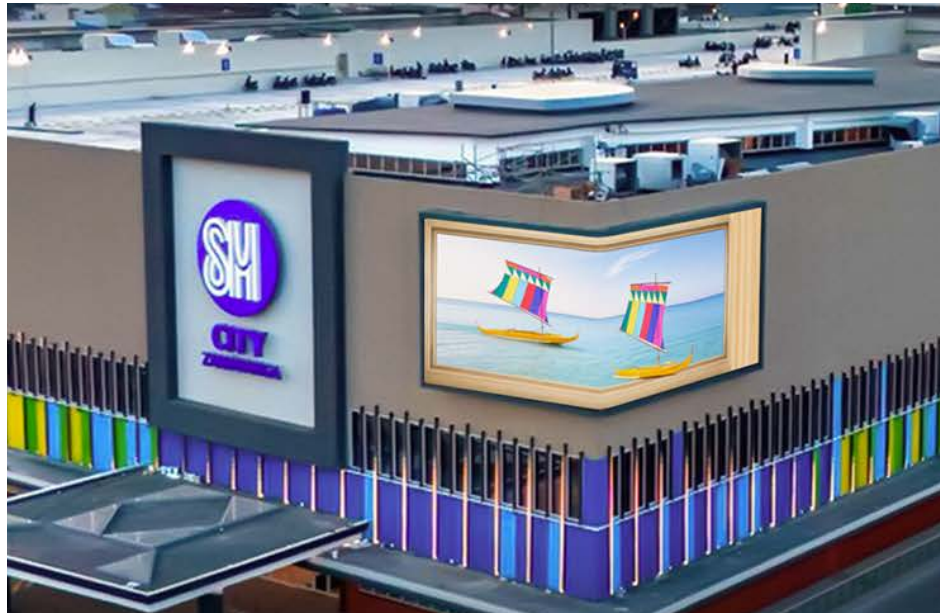
SM City Zamboanga iluminado al atardecer: la pared exterior LED curva y las instalaciones luminosas del edificio crean una presencia emblemática visible desde toda la ciudad, respaldada por la red de señalización centralizada de CAYIN.
